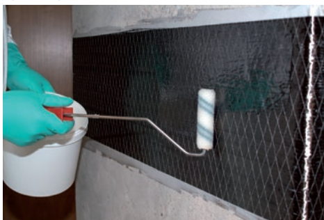
Laminace s laminovací pryskyřicí MC-CarboSolid 1209
