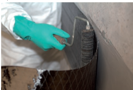
Aplikace pomocí laminovacího válečku
